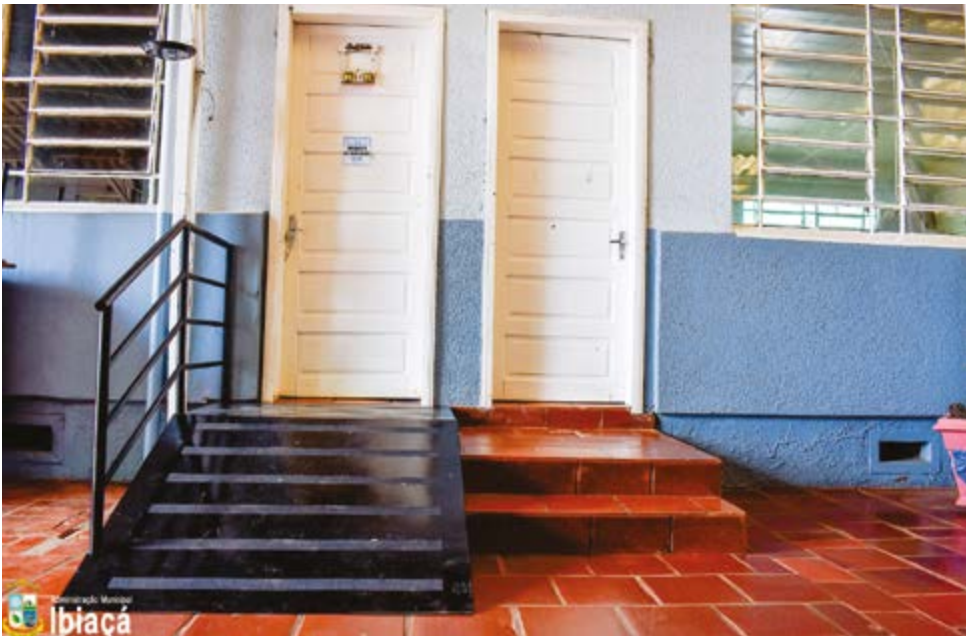
Acesso para cadeirantes e pessoas com necessidades especiais
