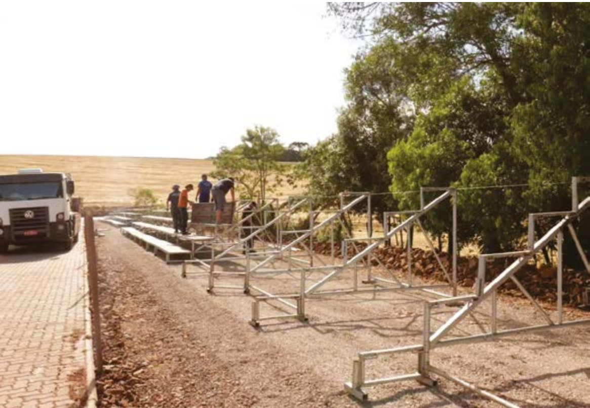
Montagem de arquibancadas da pista localizada na Linha Dalzotto
