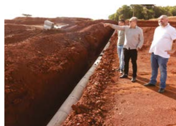
Vistoria nas obras em andamento
