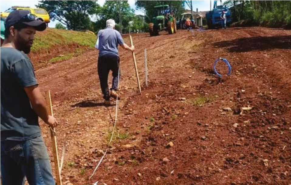
Serviços de preparação do terreno de compactação do solo
