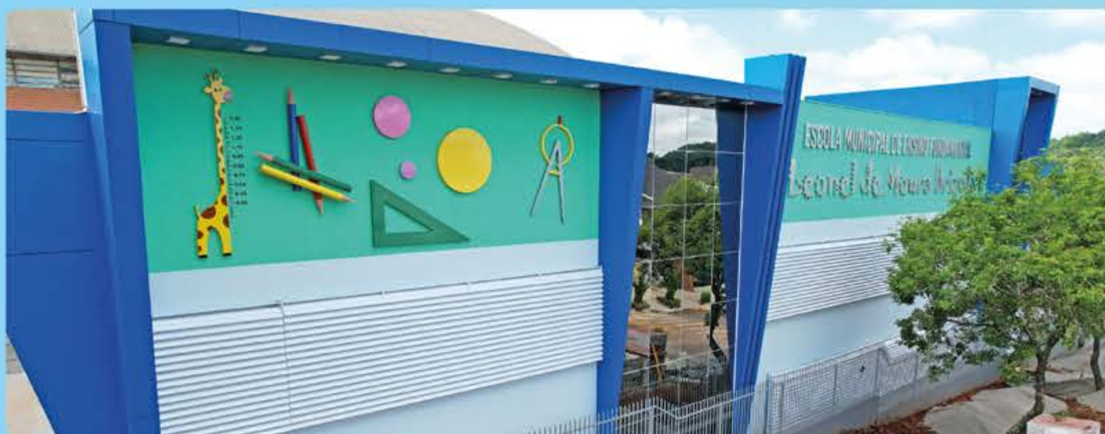
Ampliação e reforma da Escola Municipal Leonel de Moura Brizola
