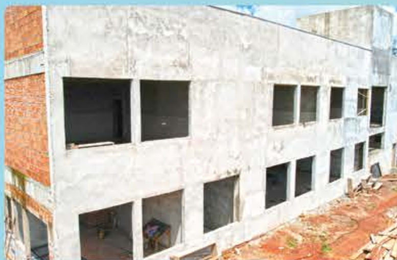
Ampliação e reforma da Escola Municipal Giocondo Canali
