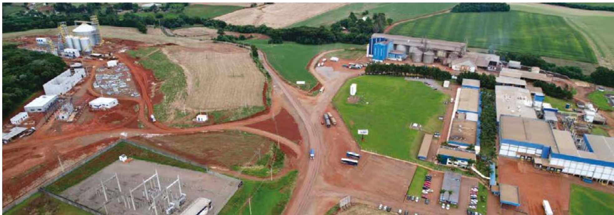
Trevo dará acesso à empresa Aurora, ao novo complexo da Agrodanieli, bem como à subestação de energia elétrica da Coprel, localizado na ERS-463
