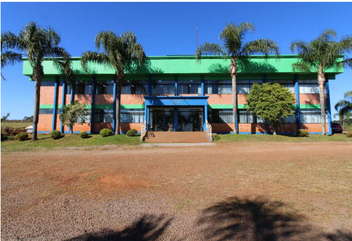
Fachada do Polo da Universidade
