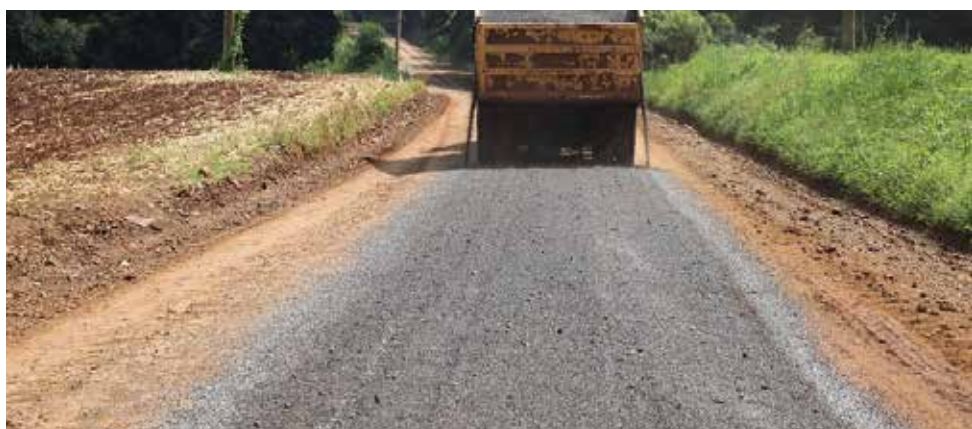
Colocação de brita
