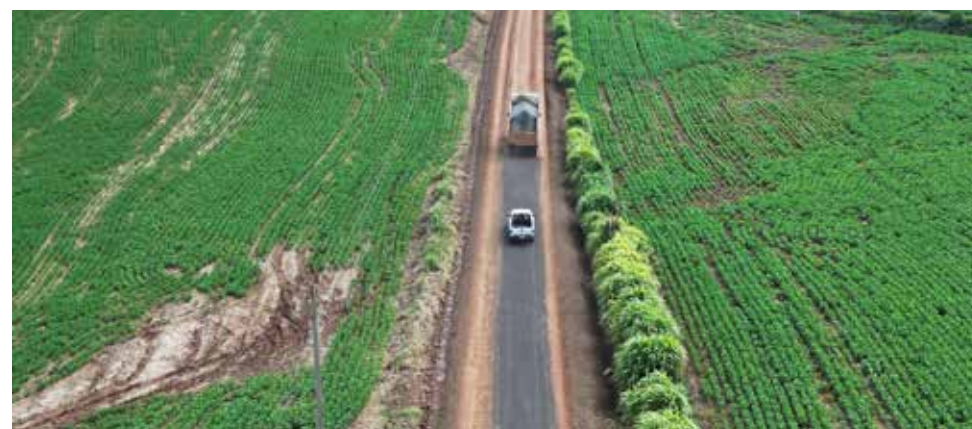
Vista aérea da estrada
