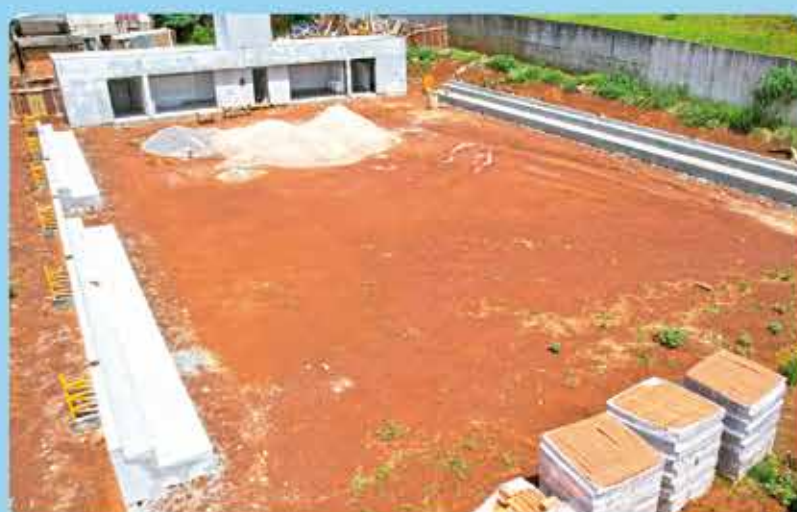
Construção da Quadra Escolar Coberta da Escola Municipal Marieli Andreola
