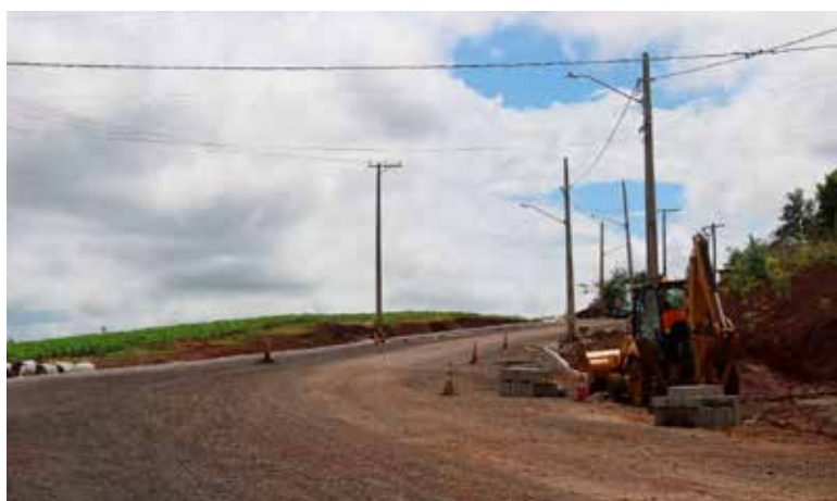
O trecho, até então não pavimentado, gerava inúmeros desconfortos
