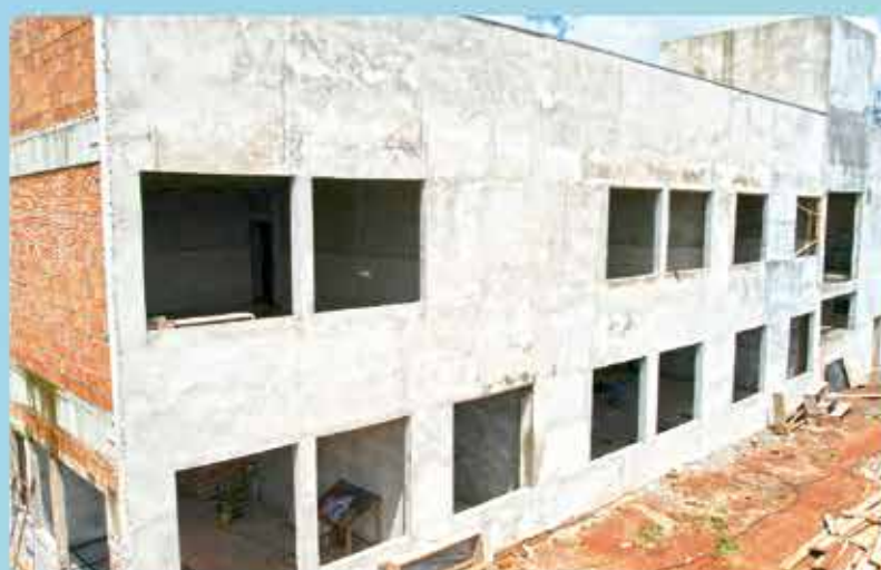
Ampliação e reforma da Escola Municipal Giocondo Canali
