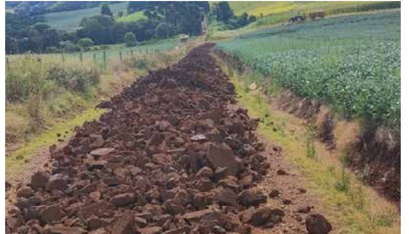
Obras estão acontecendo nas comunidades de Santa Terezinha a Santo Antônio
