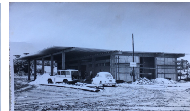
Construção rodoviária, em 1977
