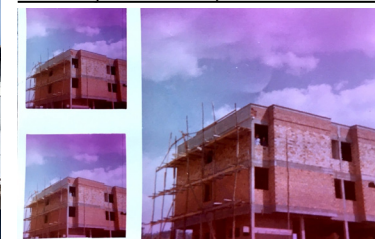
Obras de construção hotel, em 1981
