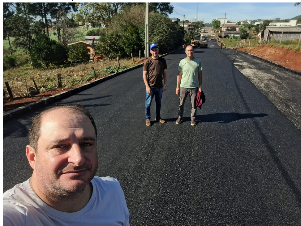
Obras de pavimentação asfáltica em andamento no perímetro urbano, resultado da parceria entre a prefeitura e o Consórcio da Região Nordeste (CIRENOR)
