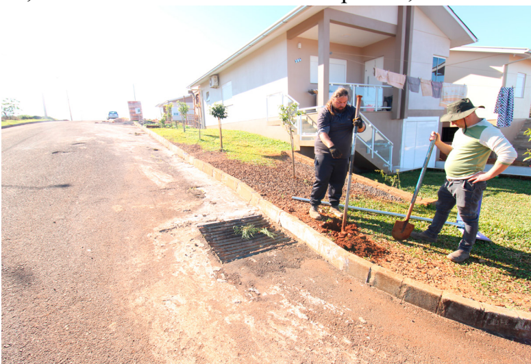
O objetivo das obras é facilitar a identificação das vias
