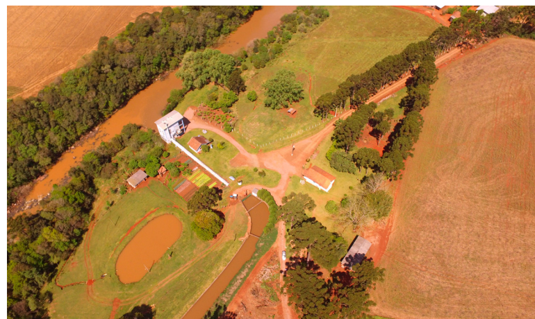
Vista aérea da usina
