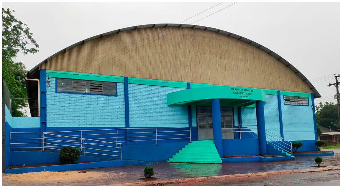
A escola Giocondo Canali é um dos locais onde as melhorias estão sendo feitas
