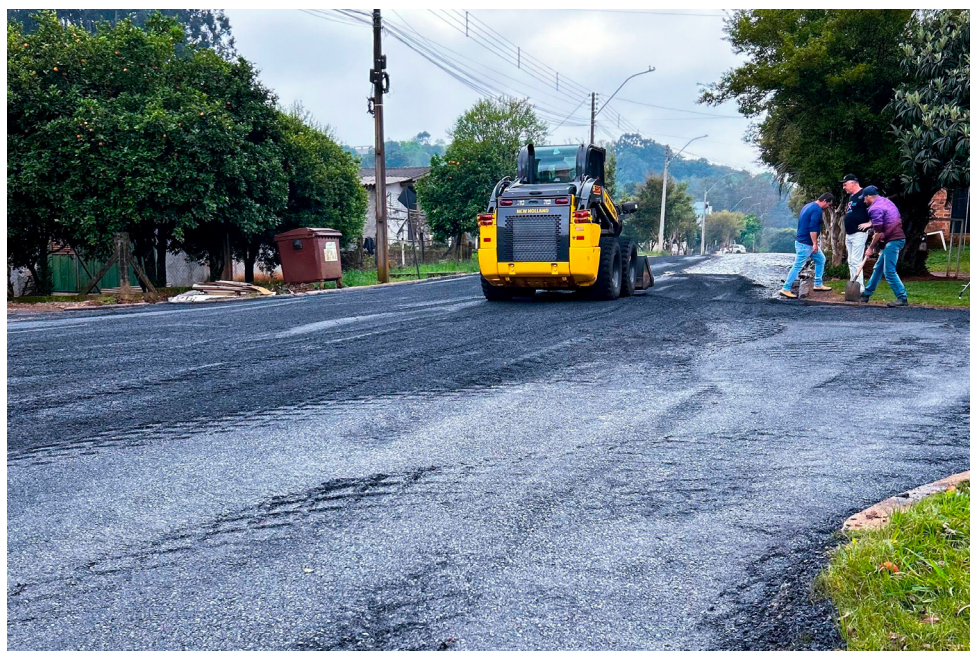
A execução das obras começou neste mês
