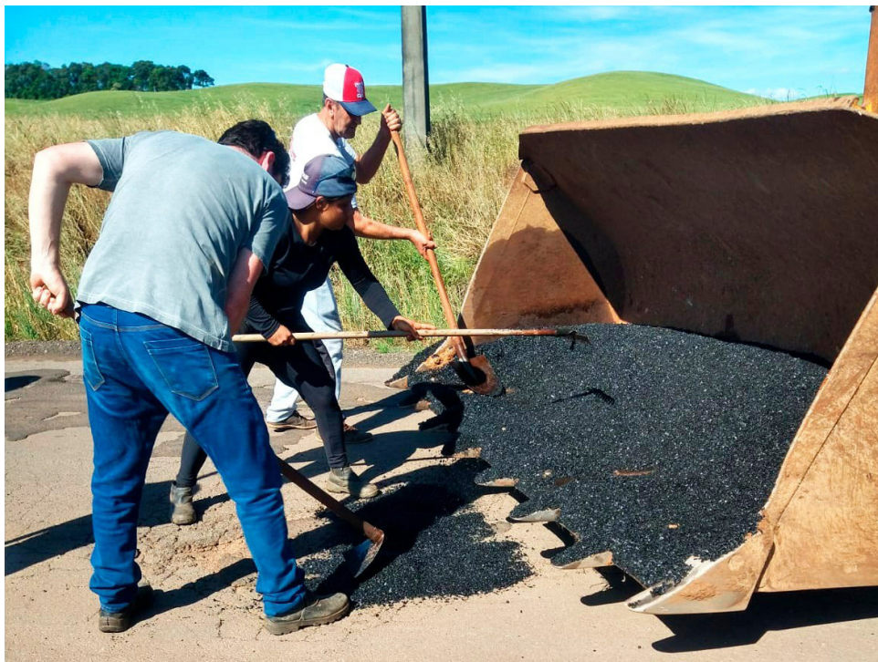
A intervenção teve como objetivo restaurar os trechos mais deteriorados do pavimento asfáltico
