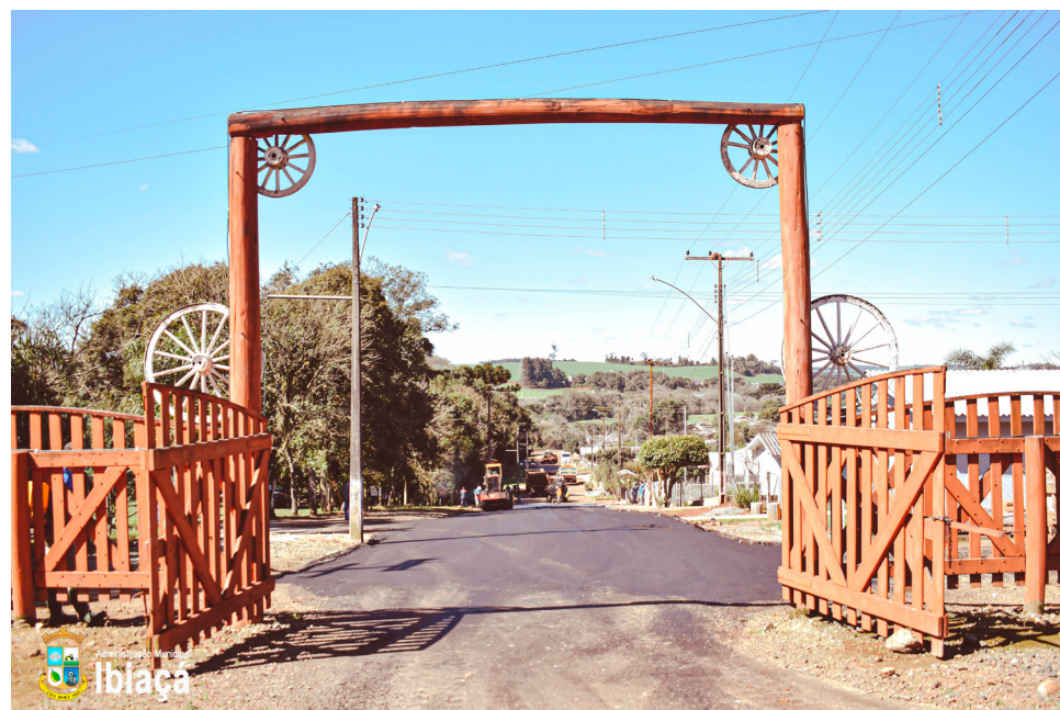
Além do Bairro Vila Nova, a reperfilagem asfáltica está sendo realizada em diversas vias do centro da cidade
