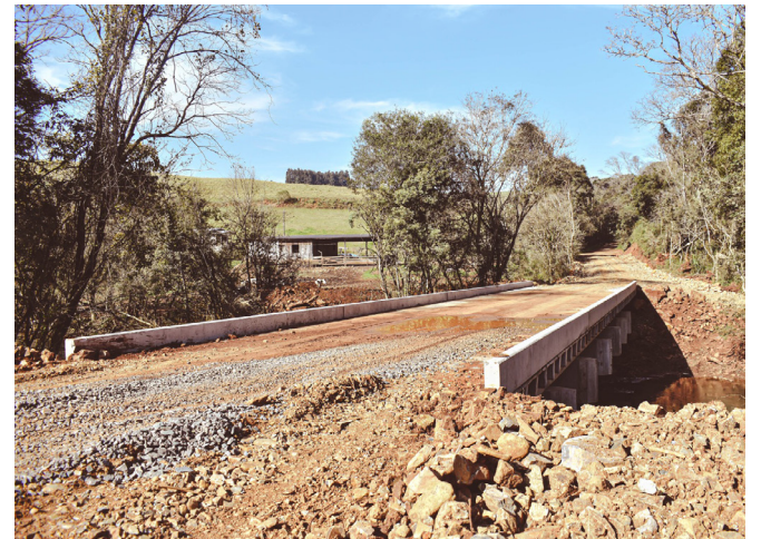
Ponte na Comunidade de Santa Bárbara
