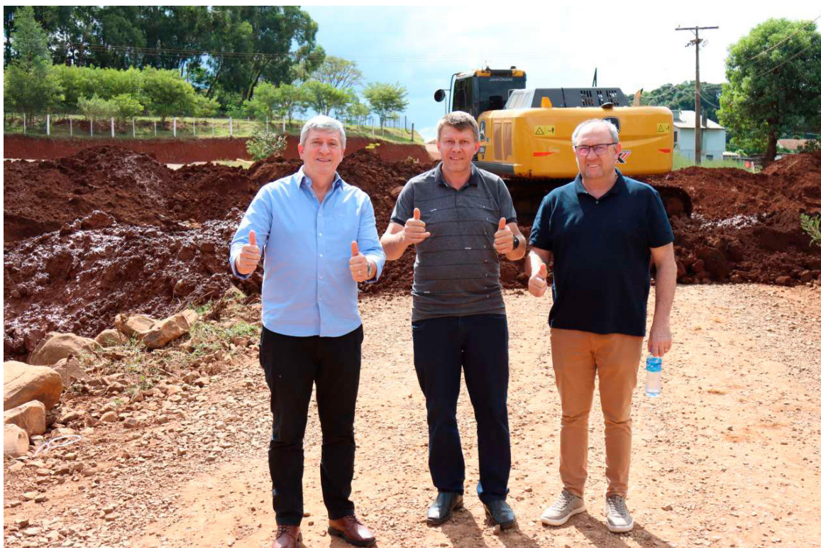
Prefeito Big, vice Gipe e secretário Clairto acompanham obras da nova ponte na Rua XV de Novembro
