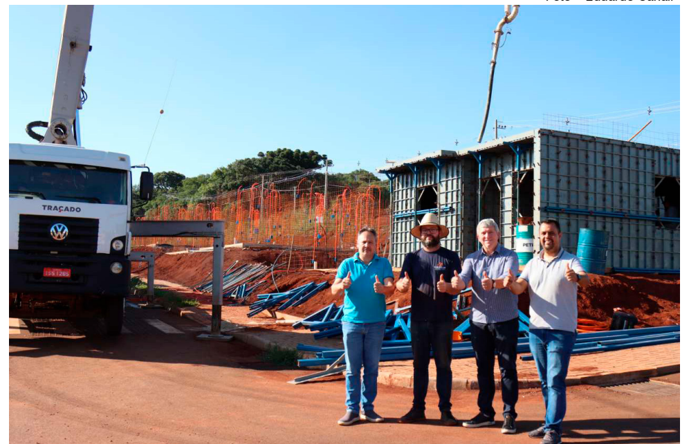
Foto - Eduardo Canali
