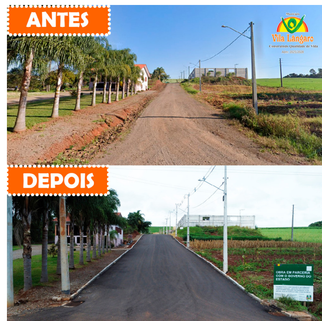
Transformação em progresso, mais segurança e conforto para os moradores com a nova pavimentação
