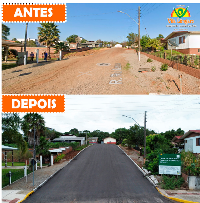
Infraestrutura renovada, obras que tornam a cidade mais moderna e organizada
