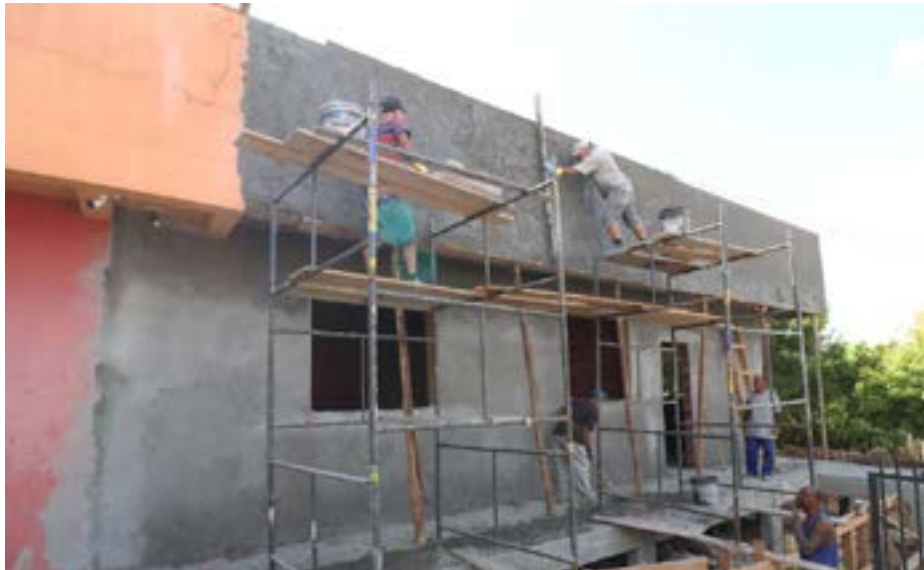
A intervenção prevê a construção de 355,14 metros quadrados
