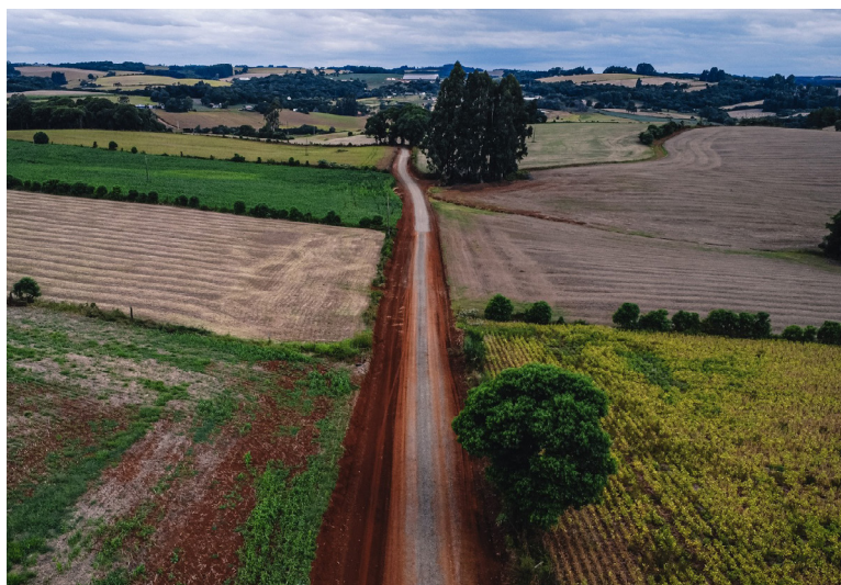
Foram feitos serviços de alargamento e patrolamento
