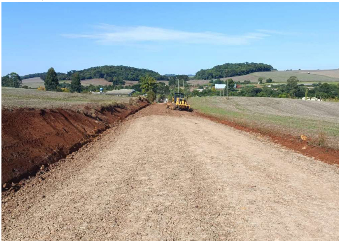
Estrada recuperada garante acesso seguro e escoamento da produção em Tapejara
