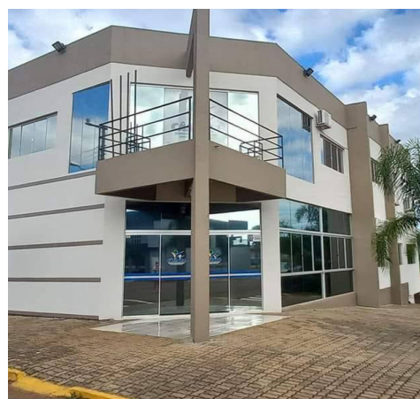
A fachada da Câmara de Santa Cecília do Sul
