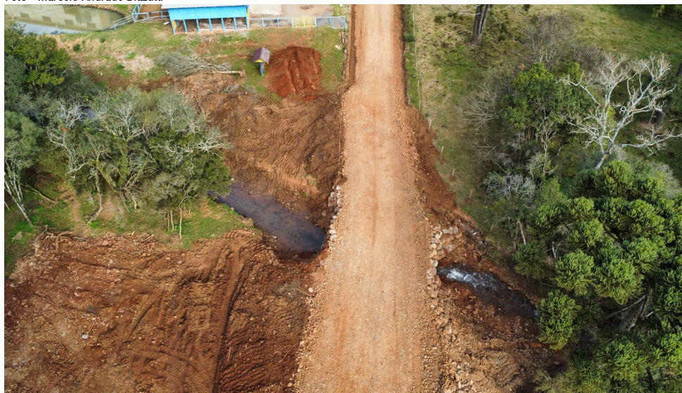
A obra reduz riscos de alagamentos
