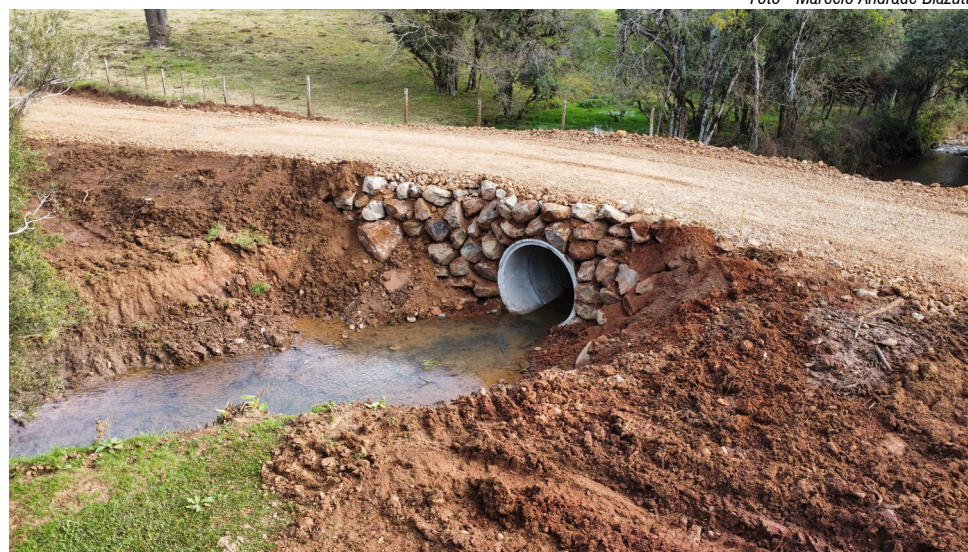
Ao todo, foram colocados nove tubos com dois metros de diâmetro cada
