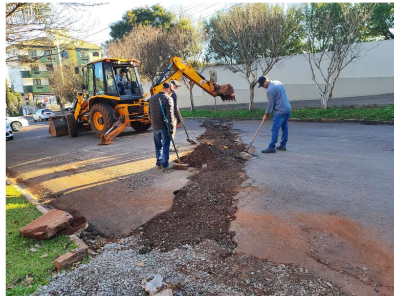
Os serviços incluem pavimentação, drenagem pluvial e manutenção de espaços públicos
