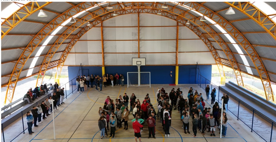
Visão interna da quadra poliesportiva coberta, com a presença dos alunos
