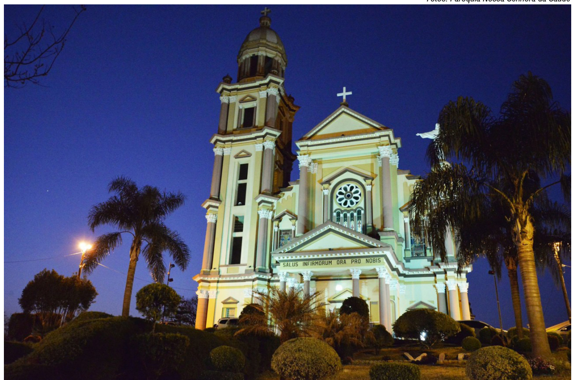
Fachada da Igreja Matriz
