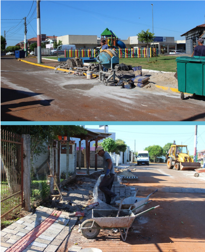
As equipes realizaram a decoração natalina, serviços de roçada, pintura do meio-fio e o conserto das calçadas no entorno da praça
