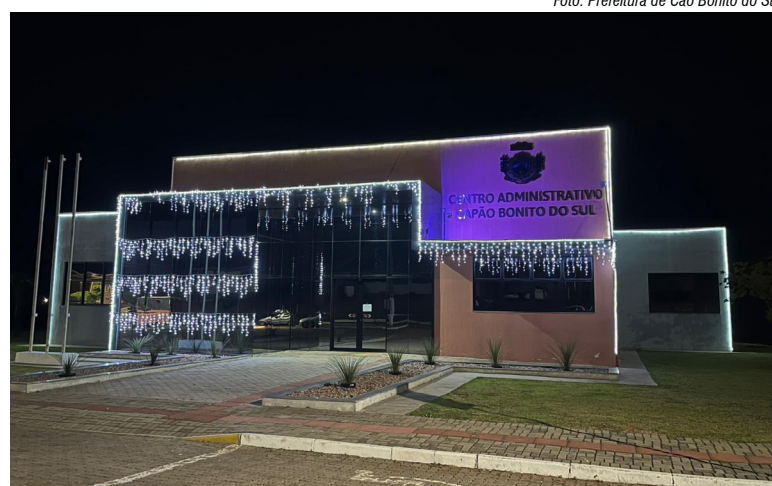
A Prefeitura reforçou que os serviços essenciais de Saúde e Água seguirão operando em regime de plantão
