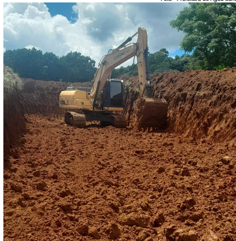
Entre os principais serviços realizados estão os trabalhos de terraplenagem
