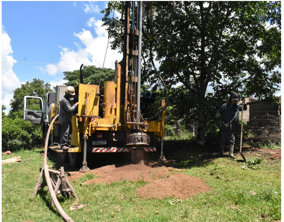
O investimento total previsto para a execução do projeto é de R$ 117.251,18
