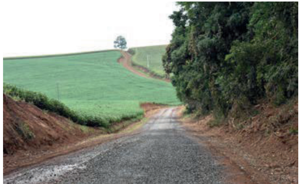
Entre os serviços executados estão o alargamento de trechos considerados críticos
