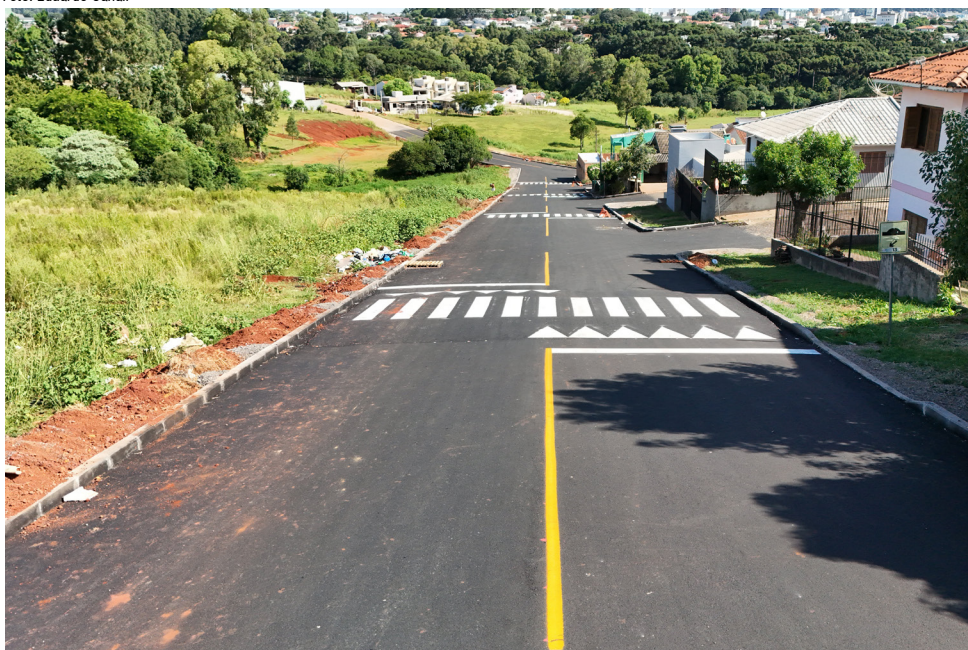
A obra abrange aproximadamente 350 metros de extensão
