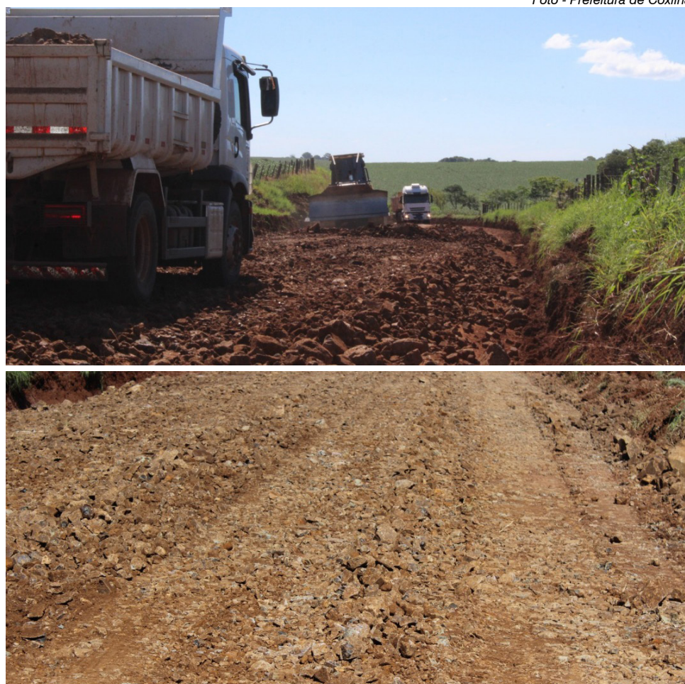
Os trabalhos incluem nivelamento da pista, reforço da base e melhoria na drenagem
