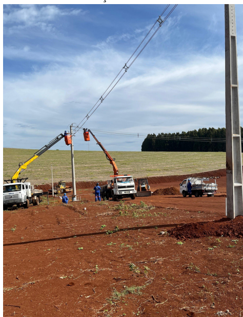
As intervenções têm como principal objetivo estruturar o loteamento para receber unidades habitacionais do programa Minha Casa Minha Vida
