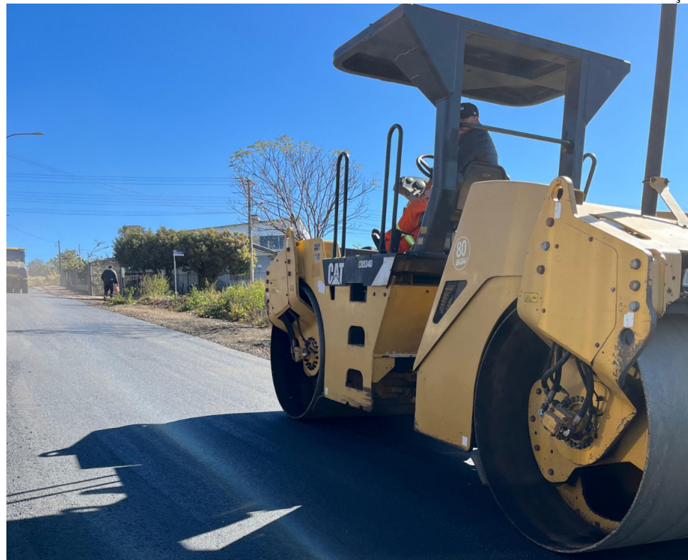
Nesta semana, a equipe responsável pelo recapeamento esteve atuando no trecho compreendido entre o Posto Comparin e o cemitério
