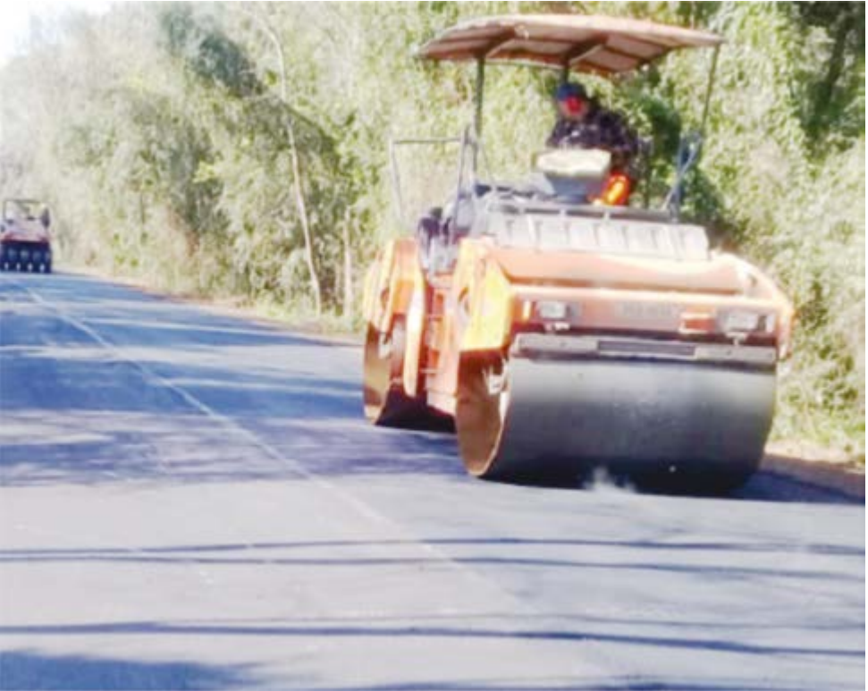
Plasbil: pavimentação da rodovia RS-430, entre Tapejara e Charrua
