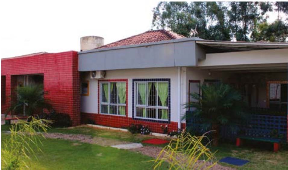
Todos os prédios terão a pintura padronizada
