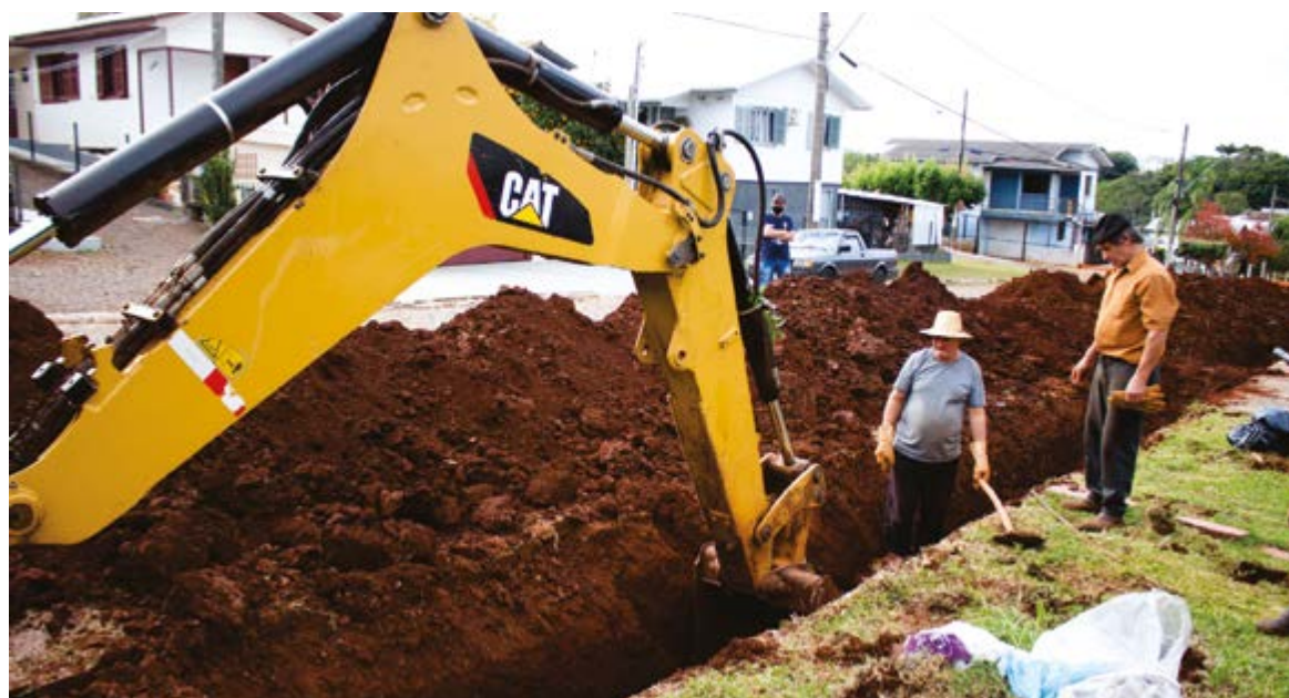
Obra no trecho compreendido entre as ruas Osório da Silveira e Amâncio Cardoso
