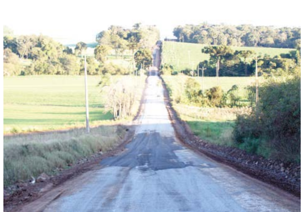
Trecho recuperado registra intenso tráfego de cargas e veículos
