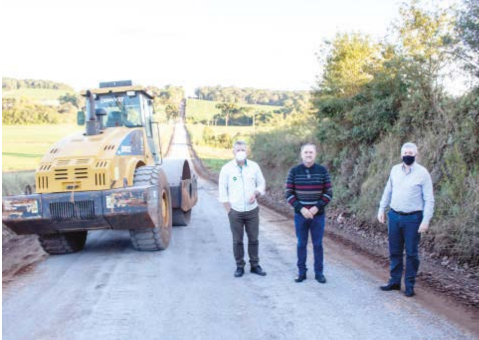
Secretário Sossella, vice Gipe e prefeito Big acompanham obras na estrada
