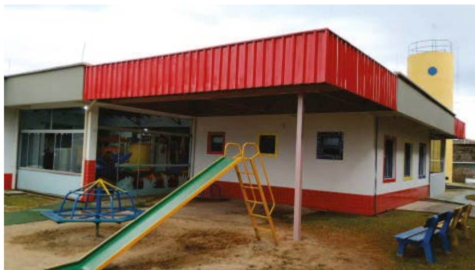
Instituição de ensino recebeu cobertura externa e outras melhorias
