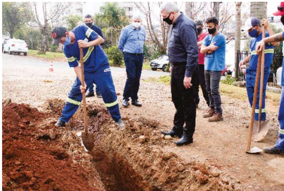
Superintendente da Corsan, Aldomir Antonio Santi, e prefeito BIG acompanham a obra
