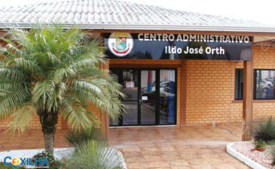
Placa foi instalada no dia 14 de julho
